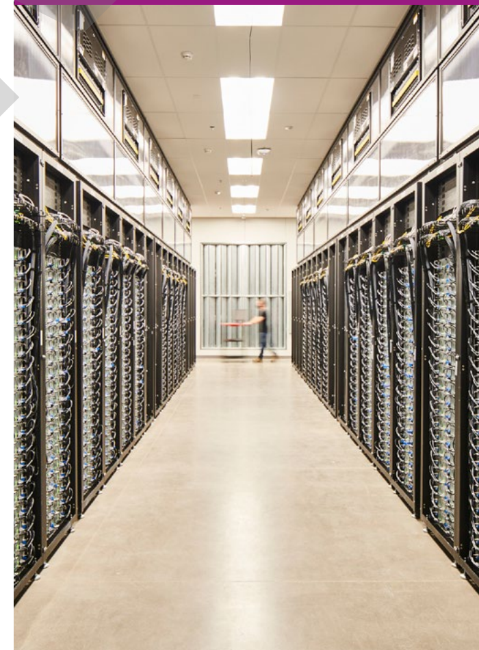
Le data center de Reno, ouvert par Apple en 2012, profite de la douceur du climat en refroidissant ses serveurs avec de l'air extérieur dès que cela est possible.
